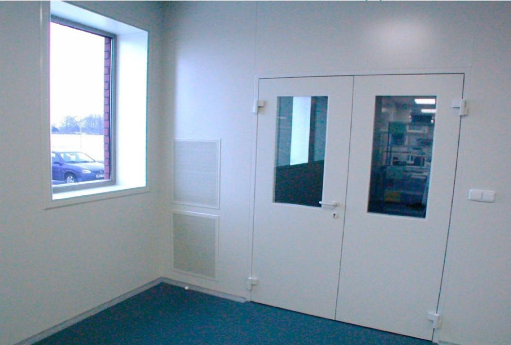
Одностороннее дополнительное остекление встраивается в существующие перегородочные панели толщ. 60, 80, 100 и 120 мм. Окно состоит из внутренней рамы, облицовочной рамы, профиля жёсткости и стекла.
