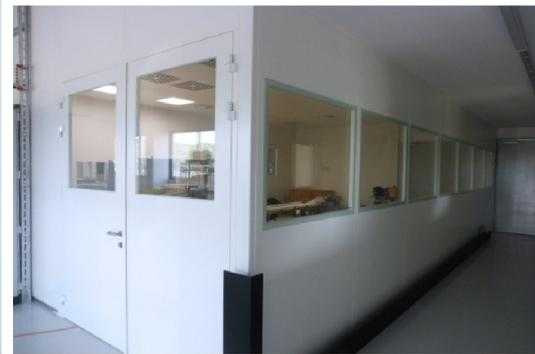
Оконная панель с полным остеклением представляет собой систему перегородочных панелей - один из основных элементов для создания чистых помещений и рабочих мест с максимальной безопасностью, стерильностью, гигиеной, простой очисткой и санитарной обработкой.
