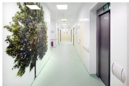
Графическая панель представляет собой современное, дизайнерское решение части системы перегородок для создания чистых помещений и рабочих мест с максимальной стерильностью, гигиеной, простотой обслуживания и санитарии. Установка панели подходит для области здравоохранения (операционные залы, комнаты отдыха, отделения интенсивной терапии, различные отделы и коридоры), фармацевтической, машиностроительной, электротехнической и химической промышленности.
