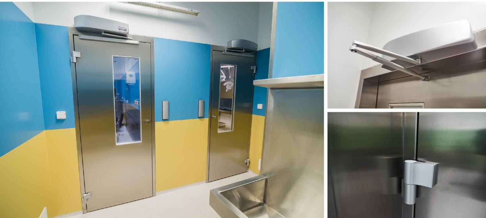
Металлические поворотные двери вместе с дверной коробкой представляют собой один из основных элементов для устройства чистых помещений и рабочих мест с максимальной безопасностью, стерильностью, гигиеной, простой очисткой и санитарной обработкой.
