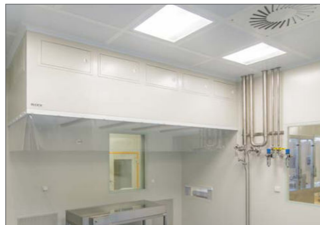
POZINKOVANÝ PLECH, POVRCH OPATŘEN PRÁŠKOVÝM VYPALOVACÍM LAKEM V ODSTÍNU RAL
