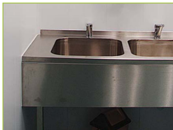
чистое исполнение со швами, замазанными герметиком
