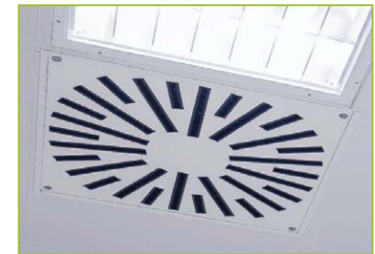
вихревой анемостат с регулируемыми пластинами
