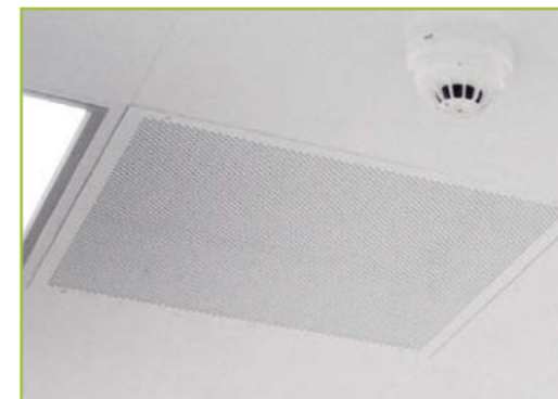
перфорированная листовая сталь со свободной площадью ~30%
