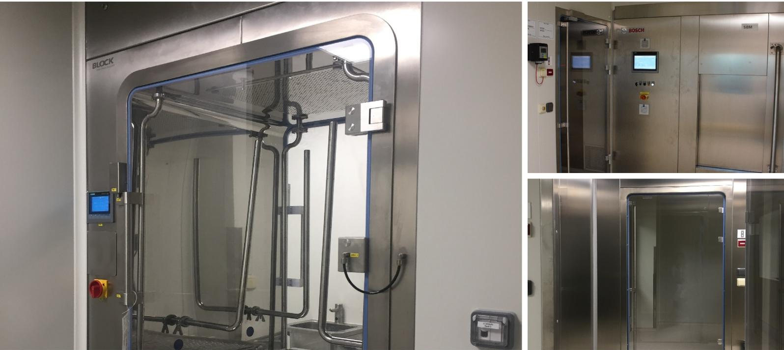
Герметичные двери вместе с дверными коробками представляют собой один из основных элементов для устройства чистых помещений и рабочих мест с максимальной безопасностью, стерильностью, гигиеной, простотой обслуживания и санитарии в вакуумных помещениях.
